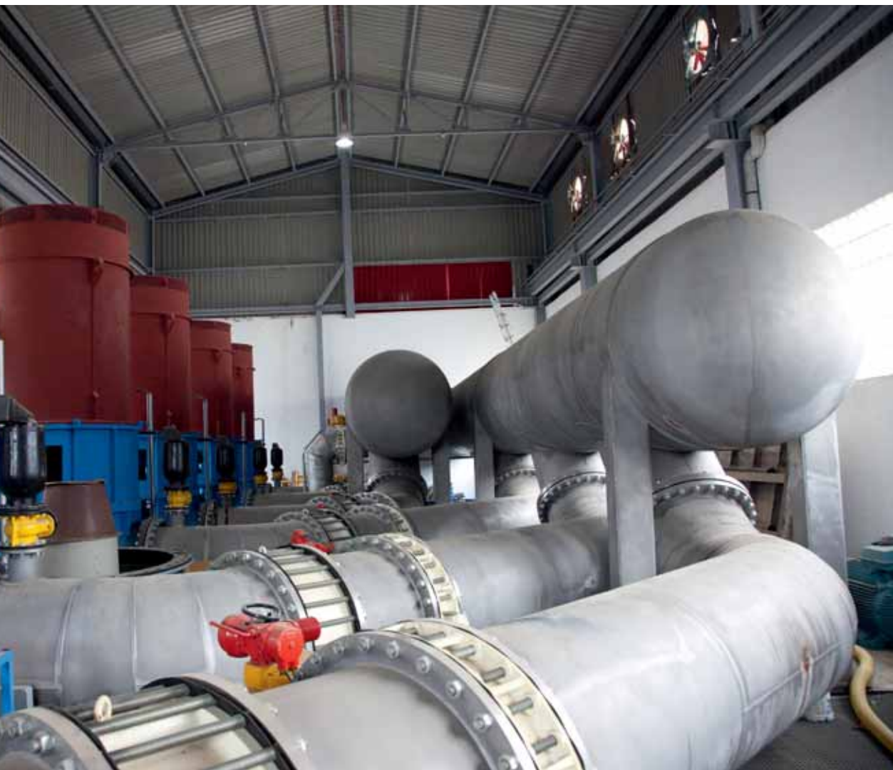
Mejora de la instalación de impulsión mediante la creación de un bicolector
