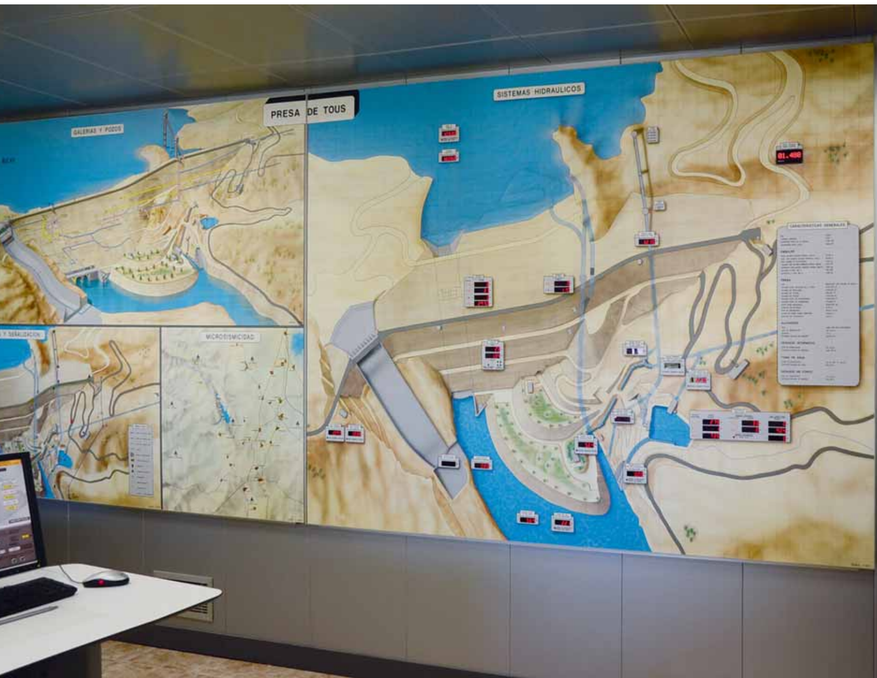
Centro de control. Videowall, monitores de seguimiento y sinóptico
